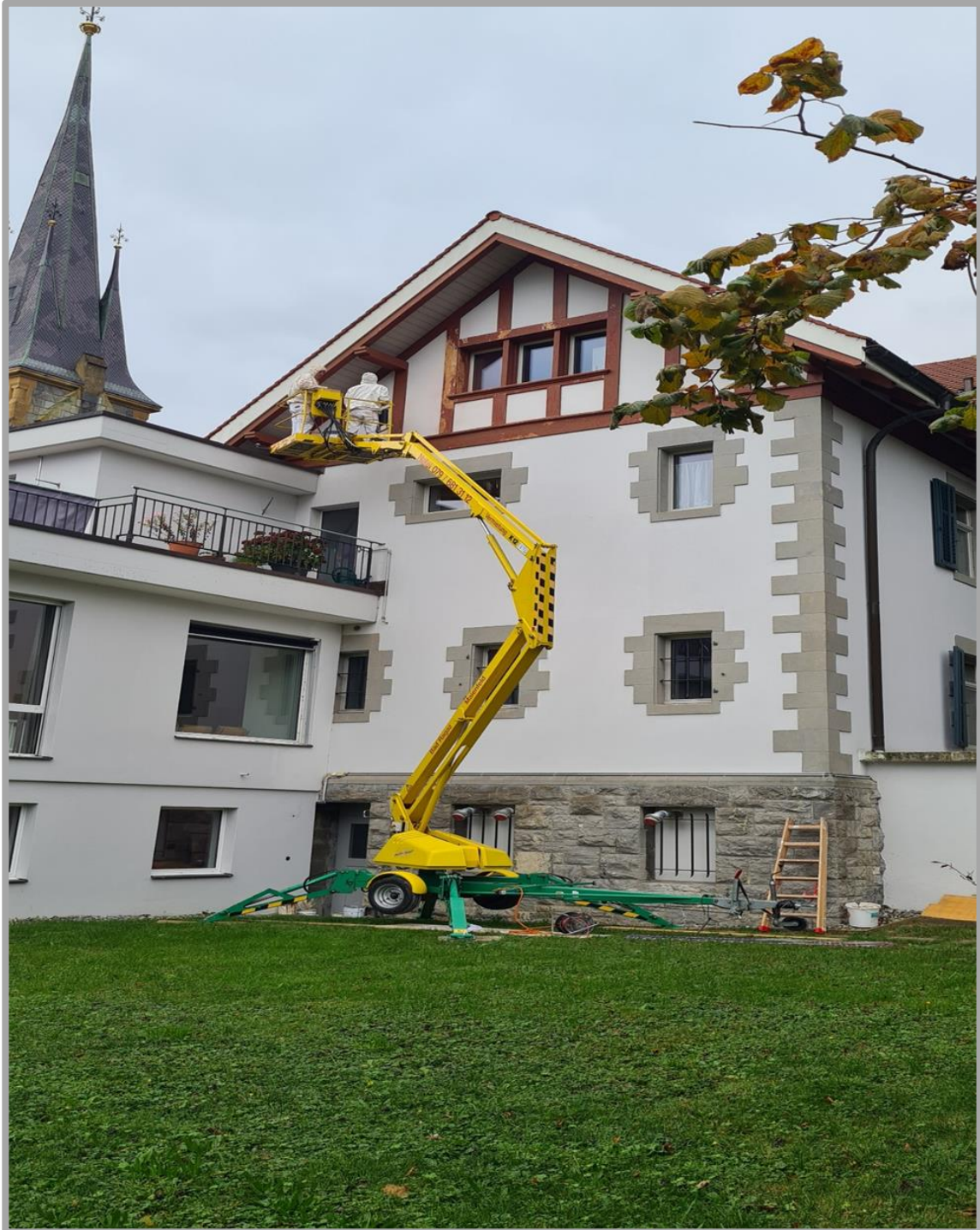
Renovierungsarbeiten am Dach
