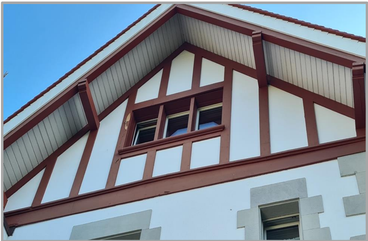
Dachuntersicht bei der Ostseite des Pfarrhauses
